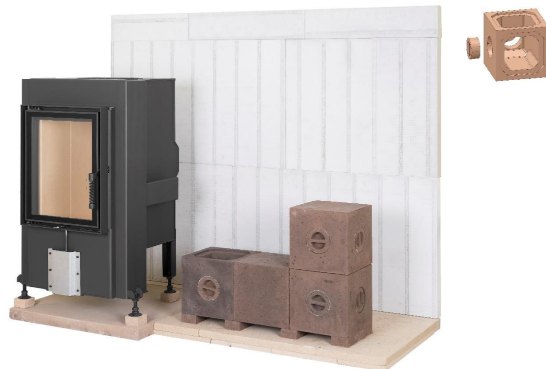
14) Ustavení tvarovky poz.5. Průběžná kontrola rovinnosti.
